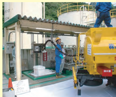
微量PCBの吸入・排出作業
