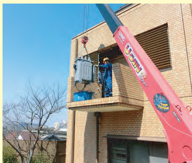
トランス搬出作業
