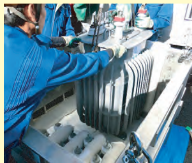
PCB廃棄物の積み込み作業
