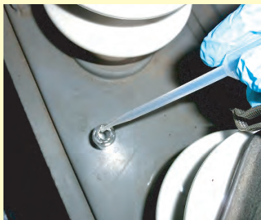
PCB含有調査(抜油作業)
